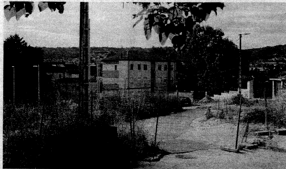
Vista de la calle de la Asunción, incomunicada por unas vallas de una obra sin terminar en As Lagoas.
